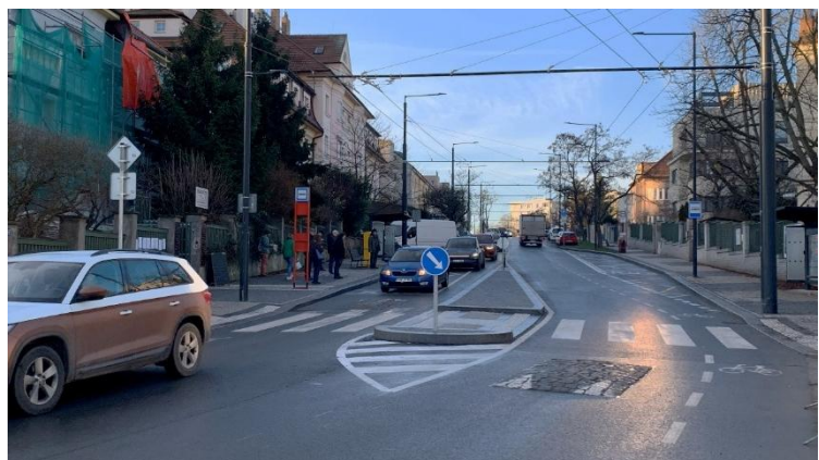
Středový ostrůvek a zpomalovací polštář před přechodem pro chodce.
